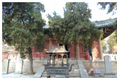
图1 初祖庵大殿现状
