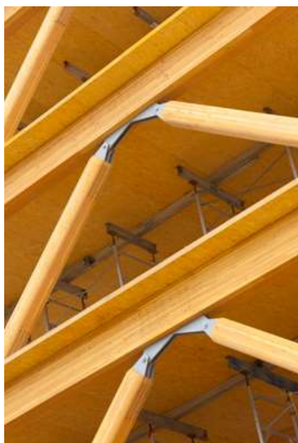
图 3.2 多层梁柱结构钢节点示意图
