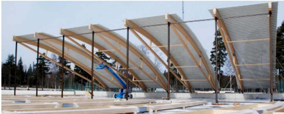
图 35. 在瑞典内斯厄(Nässjö)建造中的三铰拱架(图片提供: Sören Håkánlind)
