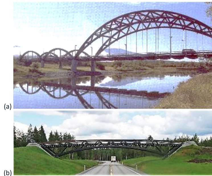
图 31. (a)位于挪威泰恩塞特的公路桥梁，采用两铰桁架拱(跨度 70 米)；(b) 位于挪威马特兰的公路桥梁，采用无铰桁架拱(跨度 32 米)
