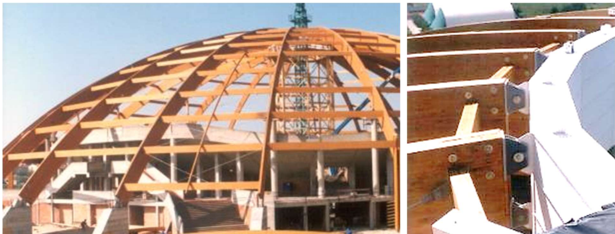
图 54. 意大利里窝那体育馆(图片由 Rubner Holzbau 提供): (a) 穹顶和 (b) 抗弯连接
