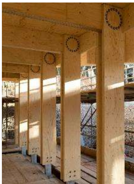
图 4. 在 LVL 梁和柱中使用圆形销钉图形的框架（图片来自 Metsä Wood）
