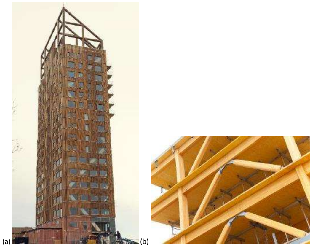
图 16. 框架支撑结构: (a) Mjøstårnet; (b) UBC 地球科学大楼 (图片来自 naturallywood.com)
