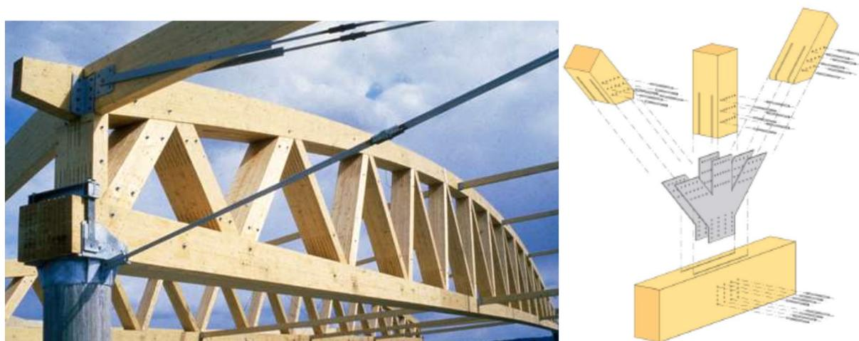
图 9 （左图）威哈马尔奥林匹克体育馆的一个胶合木桁架，上弦杆弯曲。
