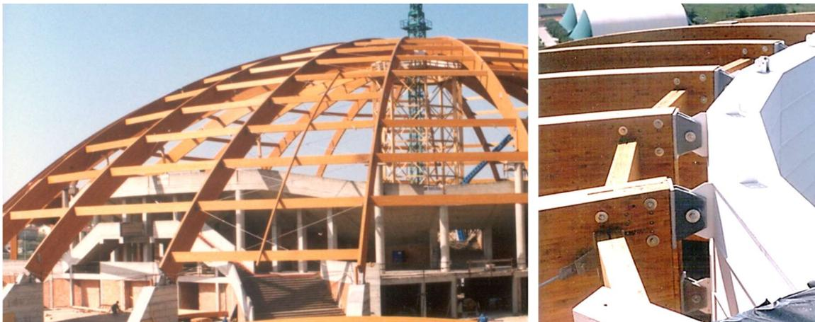
图 30 意大利沃诺一座体育馆（图片来自 Rubner Holzbau）：(a) 带肋穹顶 (b) 抗弯节点
