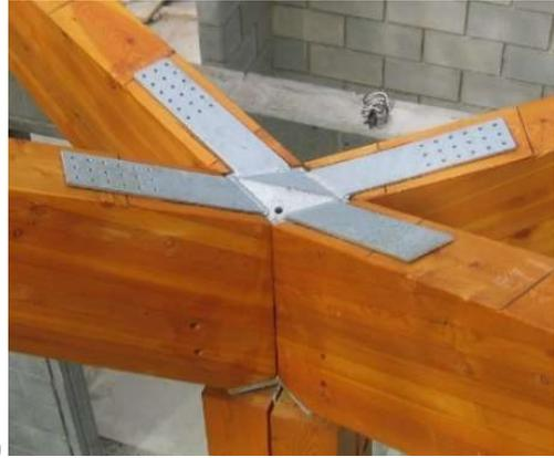
图 38 (a) 胶合木拱脚铰接连接。(b) 使用环形螺栓连接的胶合木梁柱抗弯节点。(c) 铰接节点。(d) 抗弯连接，采用自攻螺钉承担弯矩导致的拉力（待安装）。（图片由 Timber Systems 提供）
