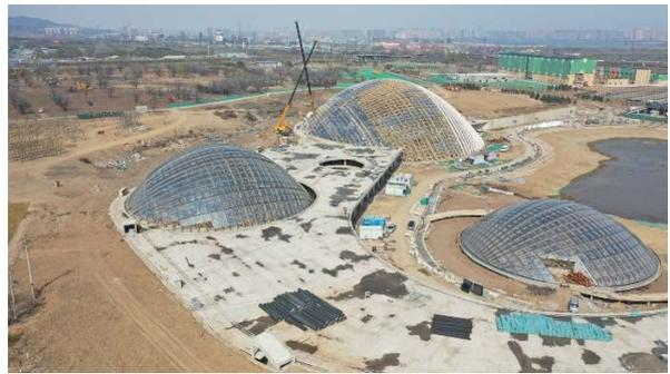
图 69 太原植物园穹顶的制造与安装（由 StructureCraft 提供）
