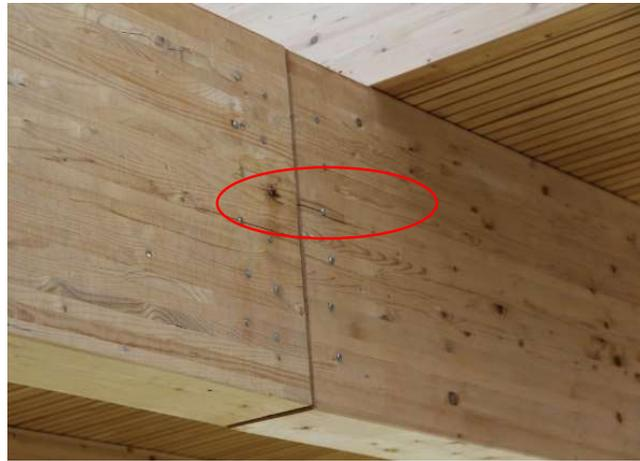
图 40 使用中胶合木梁受压与大型刚性内部钢板施加约束的协同作用，使与对齐部位产生了局部开裂
