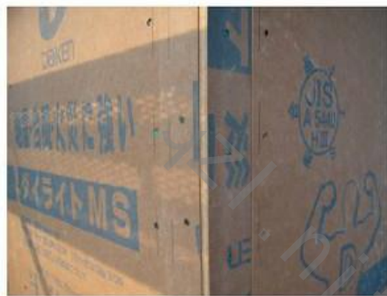
(2) 阳角处作为覆盖材的面材施工
