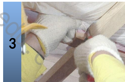
3 吊杆周围在隔热材料上开了个缺口。
