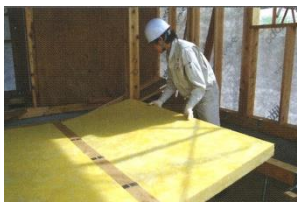
③隔热材料安装状况
