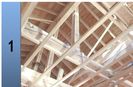
1 搭好天花板托梁后，在托梁上铺设隔热材料。
