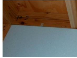
③ 隔热材料安装状况
