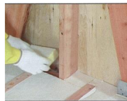
②与外墙的连接部分将隔热材料的端材填充到外墙中间。
