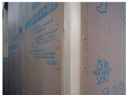
(1) 构造用胶合板等的面材施工
