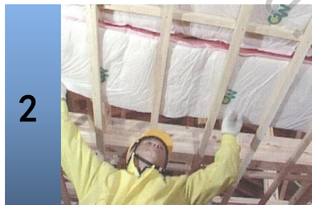
2 确保隔热材料没有缝隙。
