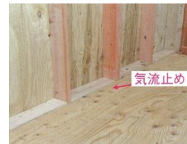
③端材施工后，用干燥木材或胶合板等设置气流阻挡装置。
