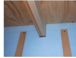
② 与外墙的连接部分施工隔热材料至外墙中间。
