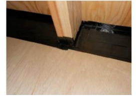
③ 与外墙的连接部分用气密胶带阻挡气流。
