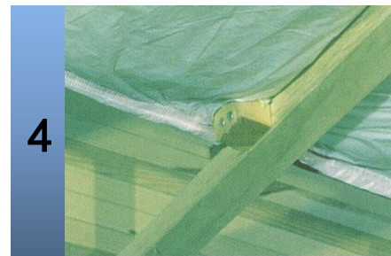
4 在吊顶托梁下贴上单独的防潮薄膜。
