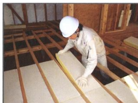
①施工状况
