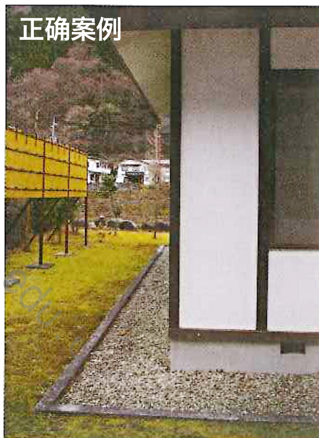
温泉入浴设施（建筑21年）建筑物四周围绕小道所铺的石渣减少了雨水的反弹
