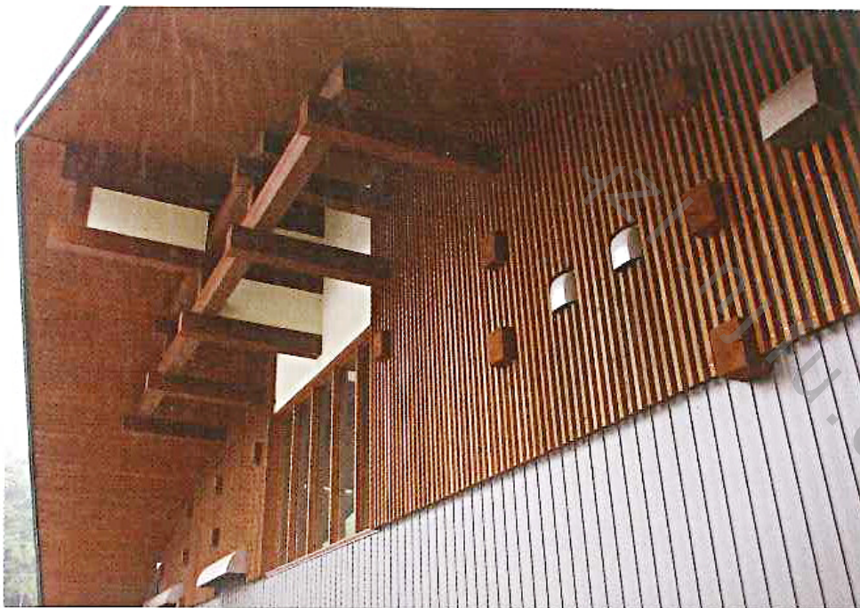
写真1 道の駅 美濃にわか茶屋(2007年竣工) けらばの出を頂上になるほど深く取ること風雨による壁面の雨濡れを軽減し、雨掛かりの多くなる腰より下の部分にはサイディングを用いて、木部をなるべく風雨にさらさない設計としている。
