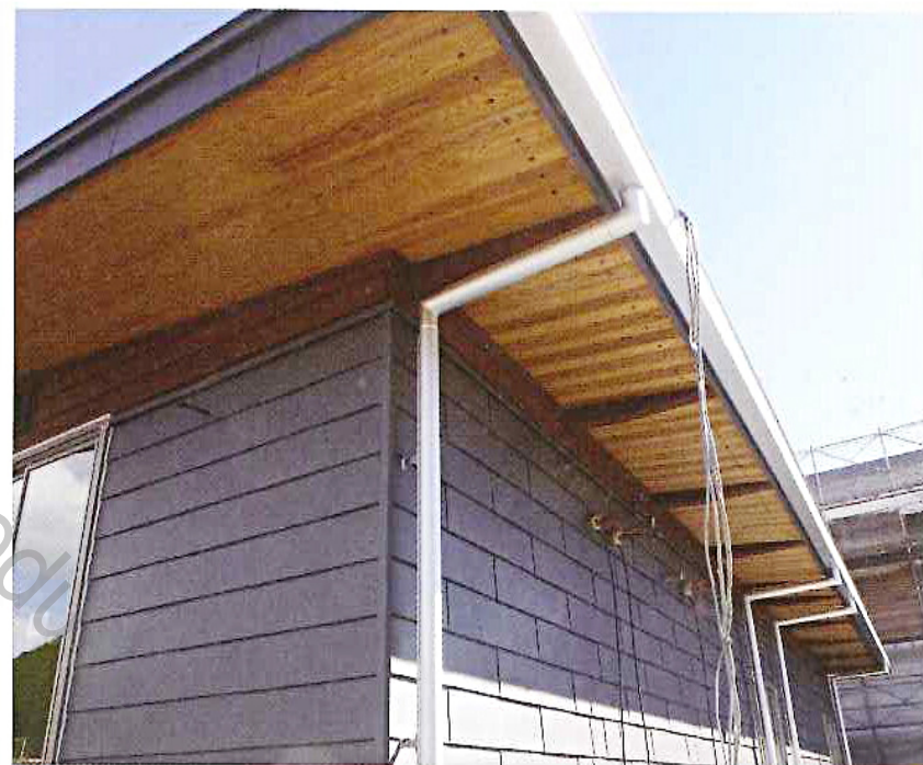
写真2 鹿沼市立栗野第一小学校(2014年竣工) 2階床ラインまでガルバリウム鋼板を張り上げ、それより上部をスギ下見板張りとしている。
